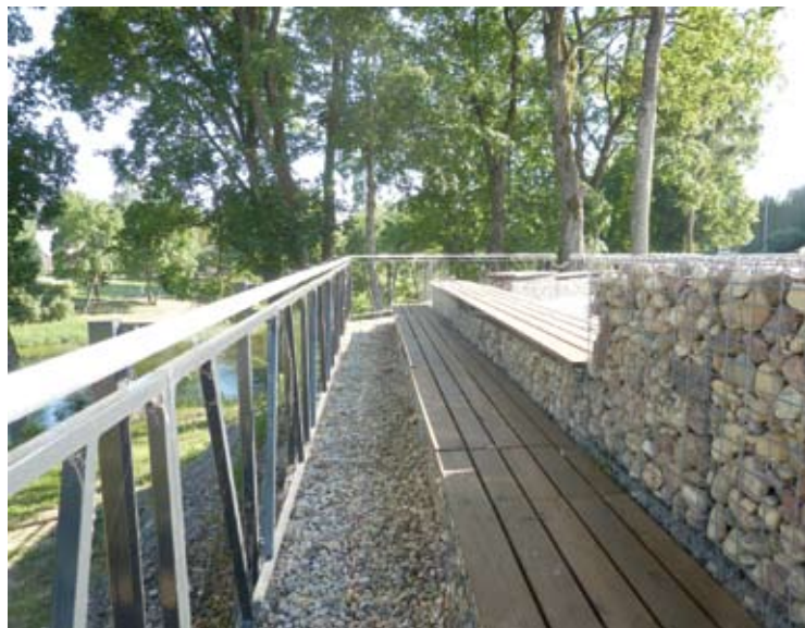
Tako sprendinius architektai vertina kaip agresyvią invaziją į Anykščių landšaftą.
